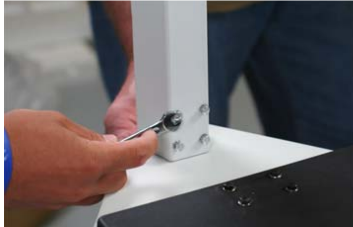
Figura 2-4. Inserte Ocho Tornillos y Roldanas para Fijar la Columna a la Base
